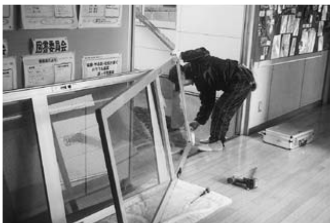
▲壊れた戸車を効率よく修理
