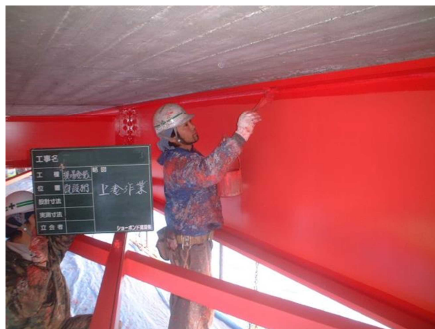
「塗り替え工上塗作業状況」 【他自治体での事例】
