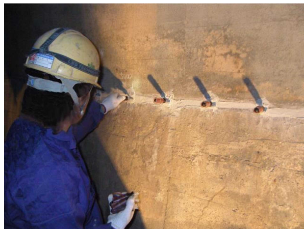
「ひび割れ注入工作業状況」 【他自治体での事例】
