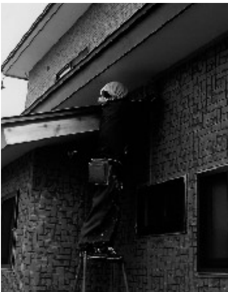
住宅の修繕・補修工事
