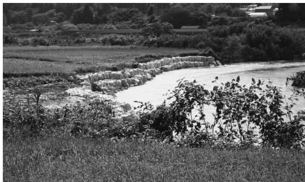
7/29 三種川の増水で決壊し、土のうで応急処置した水田(山口付近)
