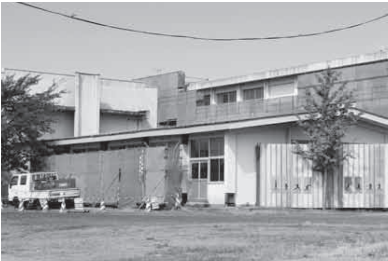
耐震改修工事が進む八竜中
