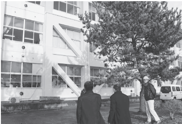
湖北小学校の現地調査
