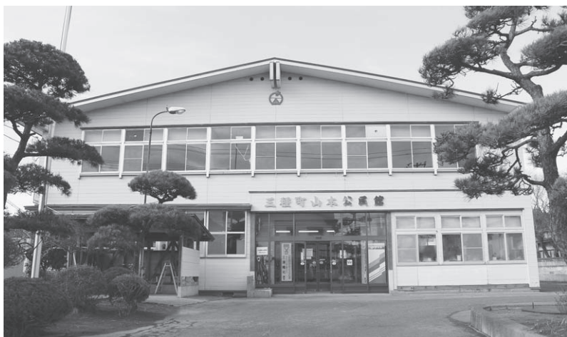
築46年経過した山本公民館
