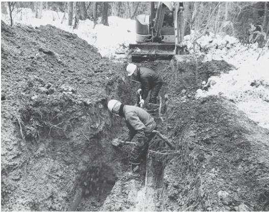
急ピッチで対応した復旧工事
