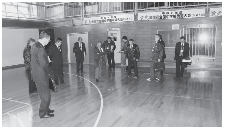
床修繕が完了した八竜中体育館
