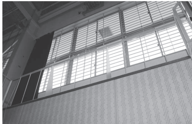
入れ替えが計画されている琴小体育館の窓枠
