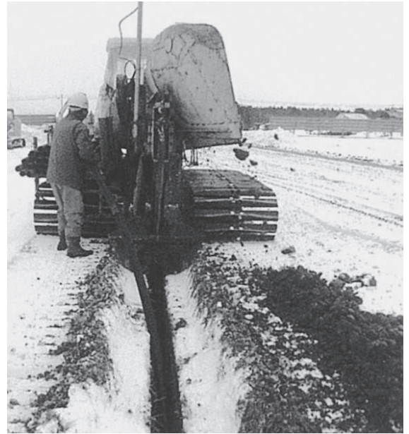
農業基盤整備促進事業の暗きよ工事
