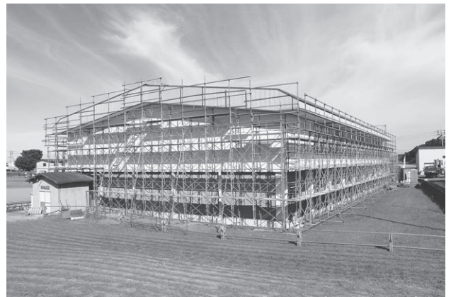
改修工事が進められている琴丘小学校体育館
