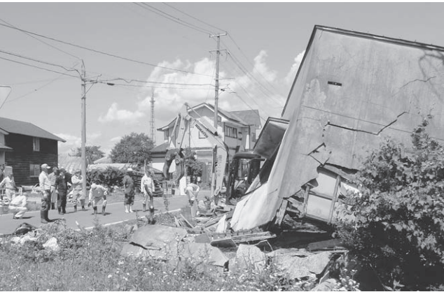
解体工事が進められた空き家
