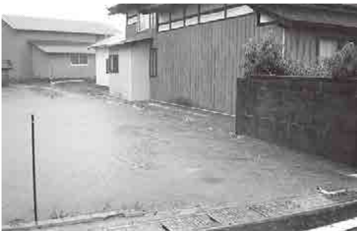
大雨で溢れる水路（鹿渡新屋敷）
