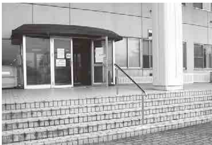
6月30日、八竜体育館にも手すりが設置された
