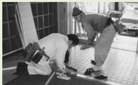
▲棚を修繕する八竜建設技能組合のみなさん
