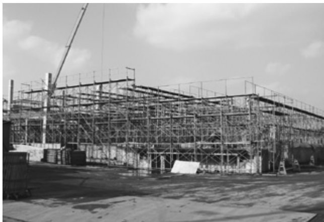
▲工事が進む学校給食センター（12/10現在）
