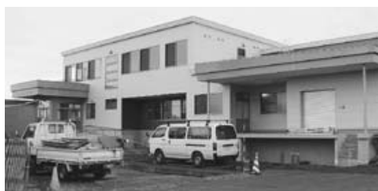
▲4月供用開始に向け建設が進む学校給食センター
