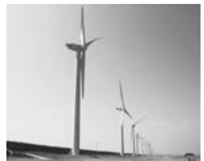
▲釜谷浜に立ち並ぶ風車群（建設中）
