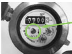
水道管に漏水があるとき、銀色部分の羽根がゆっくり回っている場合が多く見受けられます。不凍栓が完全に閉められていない場合もありますので、ご確認をお願いします。
