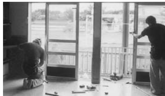
▲善意を込めて修繕作業
