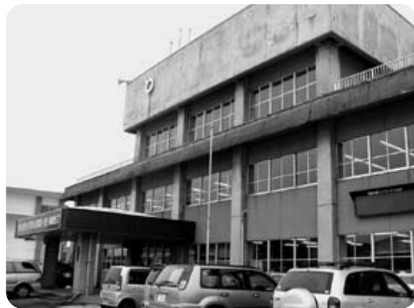
立て替えが検討されている琴丘総合支所
