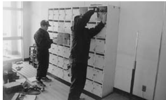
▲下駄箱を手際よく修理
