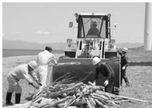
▲重機を使った大掛かりな清掃作業
