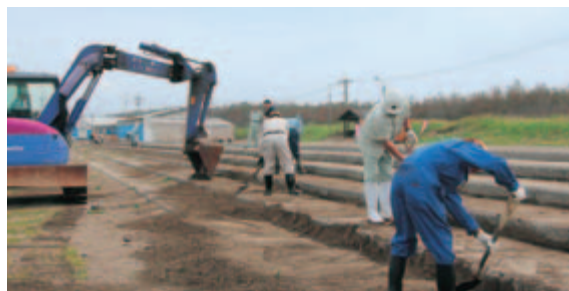
▲重機を使って効率的に作業
