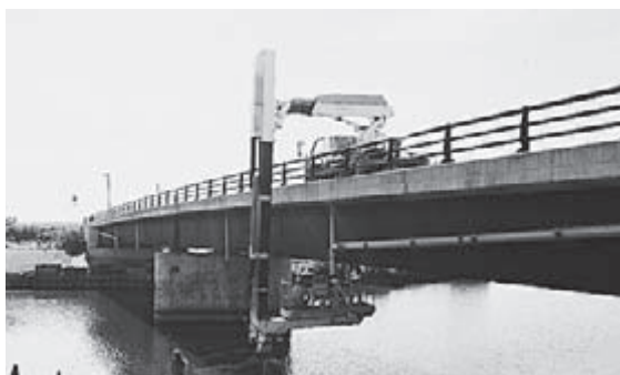
三種大橋の点検状況（H24）
