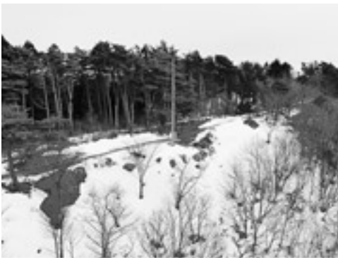
石倉山に建設中の無線鉄塔
