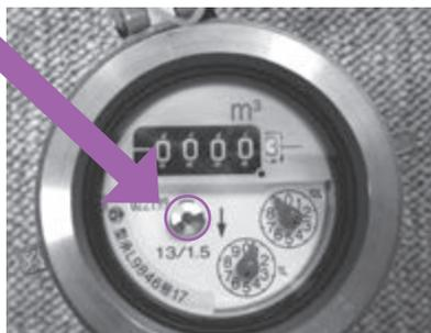
水道を使っていないのに、メーターのパイロット（風車）が回っていたら漏水の可能性があり、町の給水装置工事業者に連絡して修理をしましょう。
