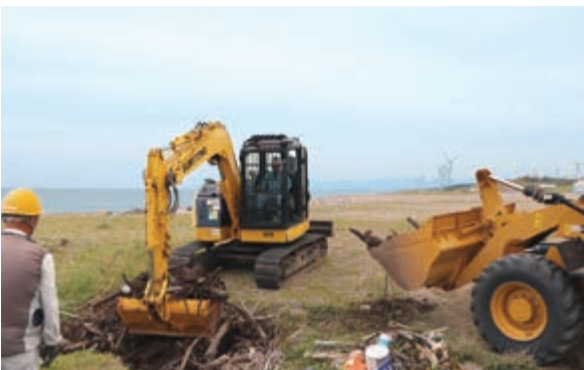
▲重機を使用した漂着物の撤去作業
