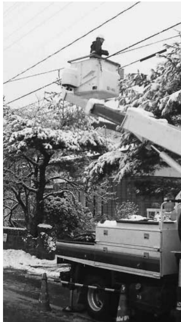
上岩川地区での 光ファイバー敷設工事
