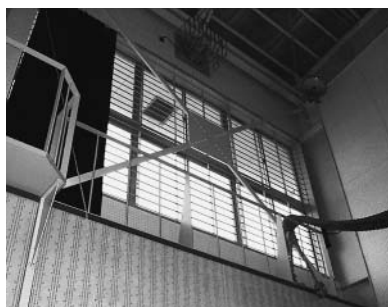
ブレース張り替え後の琴丘小体育館内
