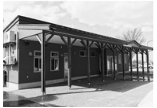
建設中の「ふるさと資源観光情報センター」
