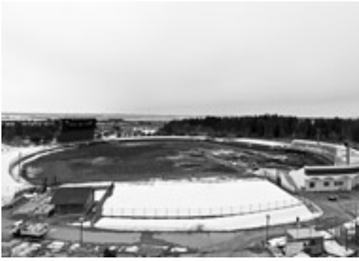
スカルパ野球場改修工事
